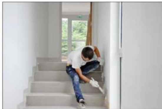
Après quelques mois de travaux, l'ancienne piscine est devenue un bâtiment industriel pour recevoir une imprimerie.
